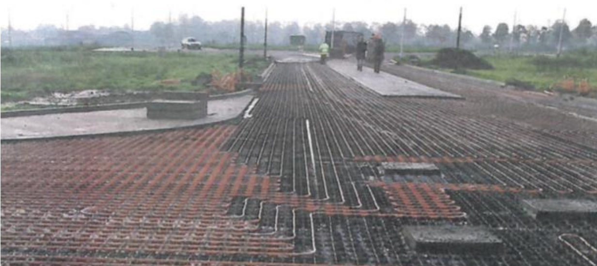
De buitenconstructie klaar om te worden geasfalteerd (Foto: Ooms Road Energy Systems)
