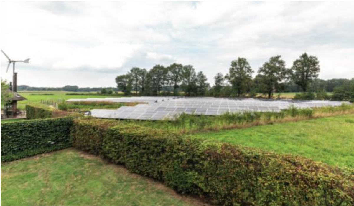
Voormalig boerenerf, bedekt met zonnepanelen. Foto: AGEM
