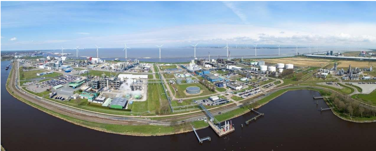
Het AkzoNobelterrein in Delfzijl
