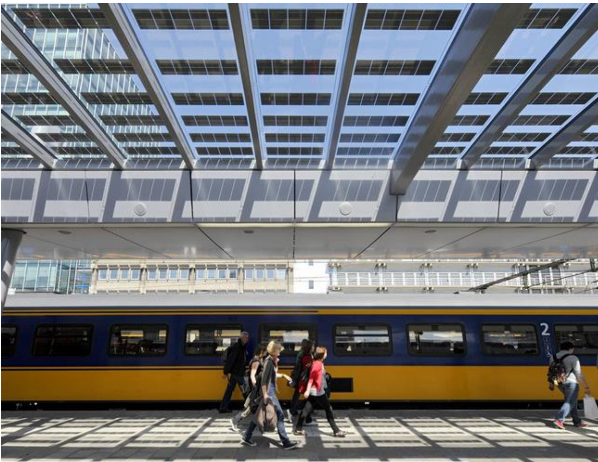
Figuur 5: Overkapping met glas-glaspanelen CS Utrecht - foto BRS Building Systems
