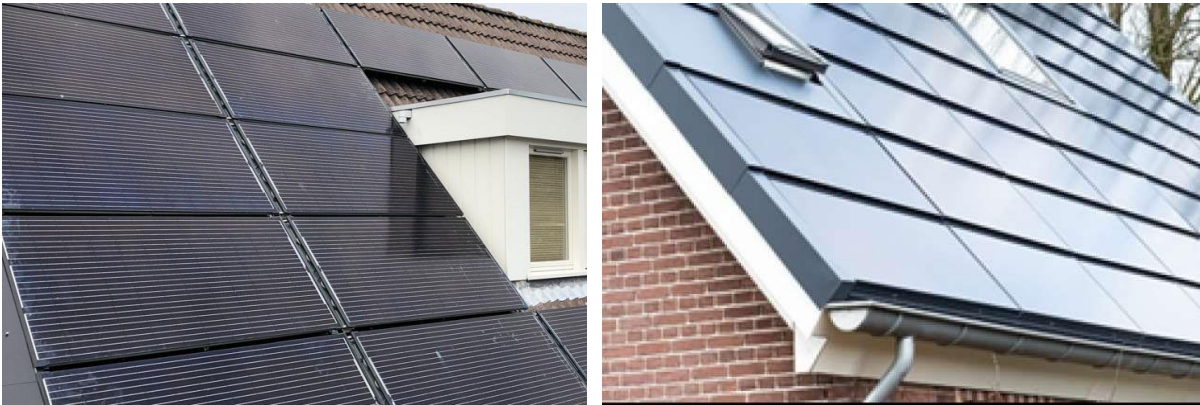
Figuur 9: Zonnepanelen die voor elektriciteit, warmte en warm tapwater zorgen. Links de oplossing van Tripel Solar, rechts die van Dimark Solar
