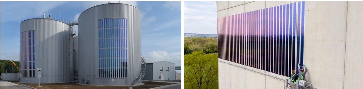
Figuur 8: Toepassingen van dunne film-zonnepanelen van Heliatek - foto's Innogy (boven) en RWE (onder)
