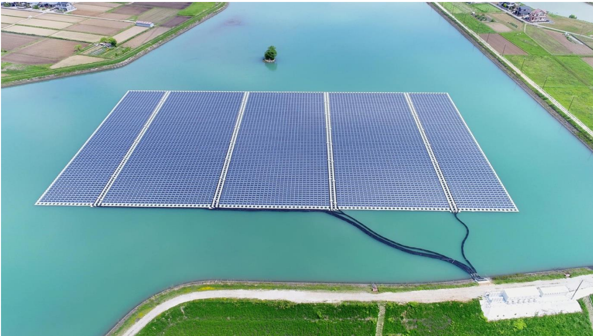
Drijvende zonnepanelen op een irrigatiebekken in Hyogo, Japan. Foto: Ciel & Terre International
