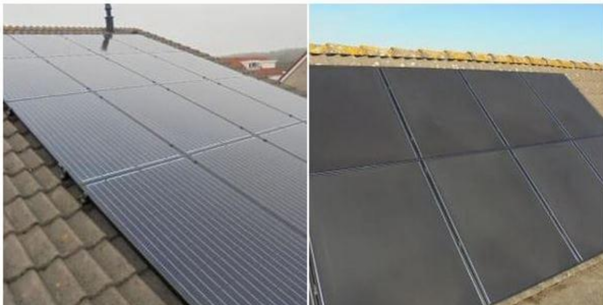
Figuur 4: Monokristallijn zonnepaneel (links) en CI(G)S paneel (rechts - foto Zonnepanelen.be)
