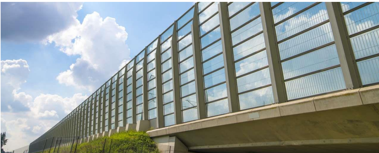
Afwerking zonnepanelen op viaduct. Foto: Rijkswaterstaat
