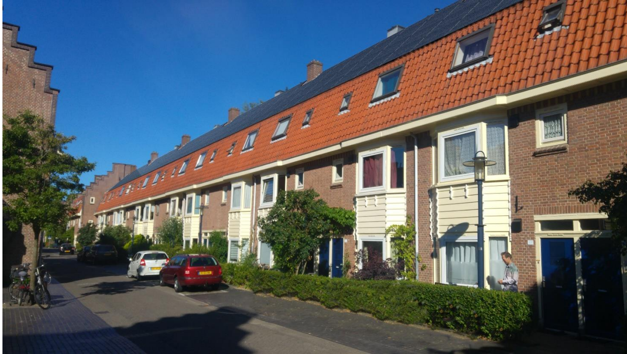
Gevelbeeld straks met zonnepanelen
