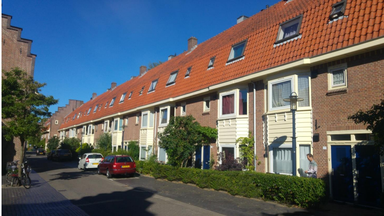
Huidige gevel kraaipanstraat
