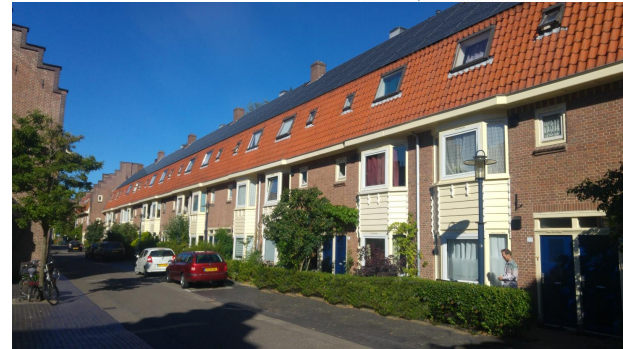
Gevelbeeld straks met zonnepanelen
