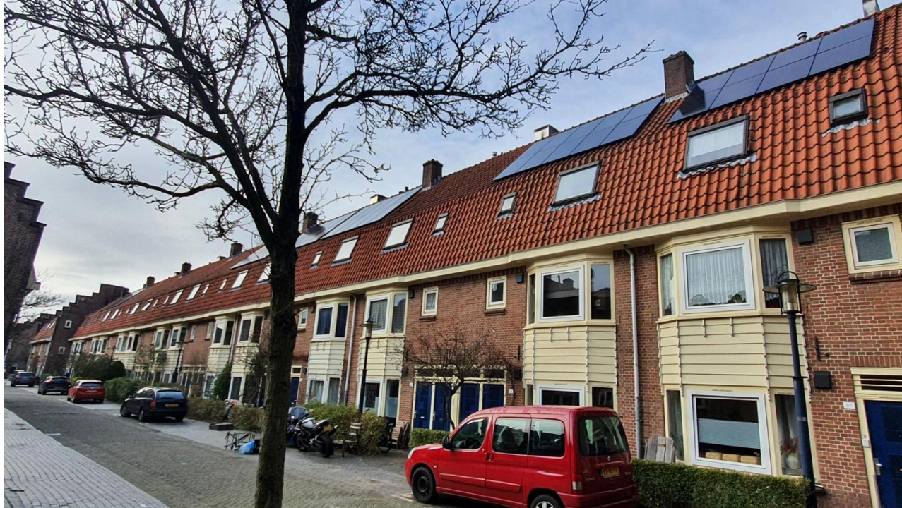
Gerealiseerde zonnepanelen op het dak
